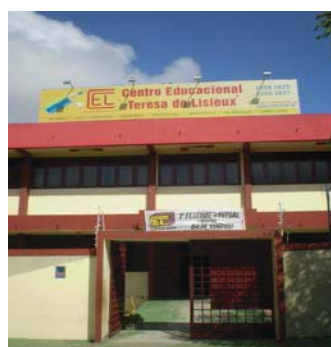
FIGURA 1 – Estrutura da escola
