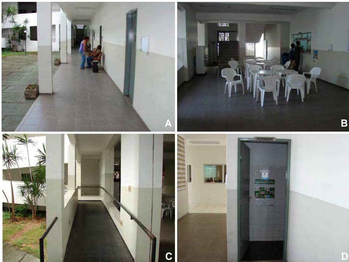
FIGURA 5 – A imagem A retrata um dos corredores, a imagem B a cantina da escola, a imagem C uma das rampas de acesso à cadeirantes e a imagem D a entrada de um dos banheiros masculinos, evidenciando ausência de placa indicativa em Braille.
